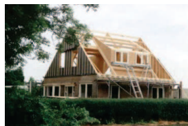
Tijdens de bouw
