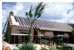
Tijdens de dakrenovatie
