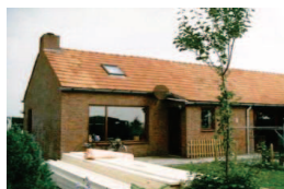
Voor de dakrenovatie
