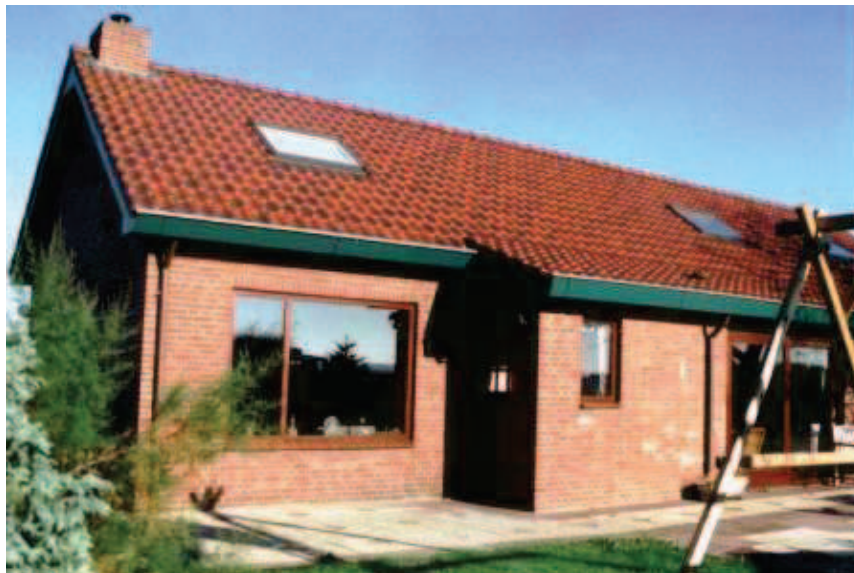
Na de dakrenovatie
